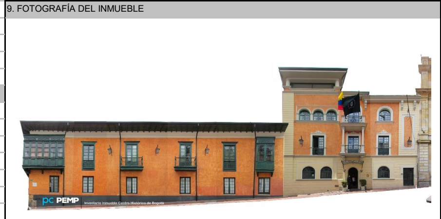
Fuente: Equipo Fotografía PEMP Patrimonio Inmueble
